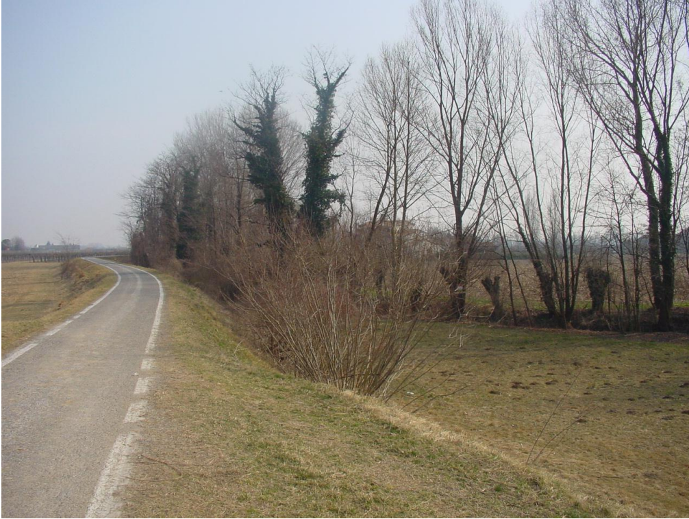
1 – Argine Canale Negrisia
