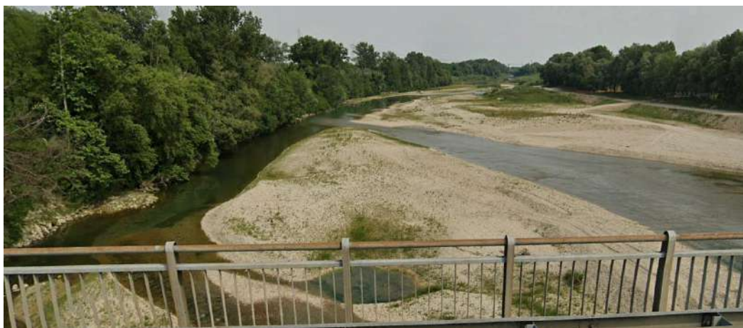
Figura 35. fiume Piave a valle del ponte della SR 53.
